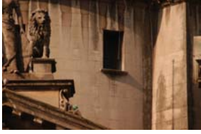
DCH Dome 16.JPG
