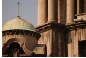
DCH Dome 07.JPG
