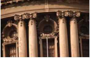
DCH Dome 10 & 12.JPG
