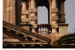
DCH Dome 41.JPG
