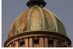
DCH Dome 18.JPG
