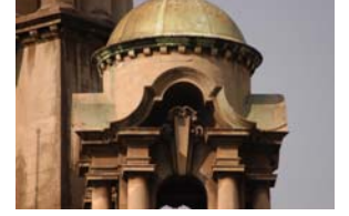
DCH Dome 42 & 43.JPG
