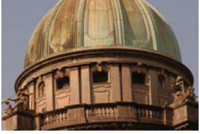
DCH Dome 4.JPG
