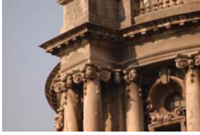
DCH Dome 5 & 6.JPG
