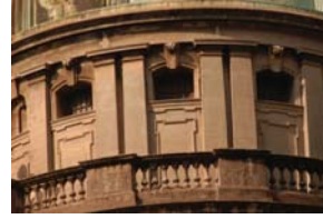
DCH Dome 8 16 13 14 & 15.JPG
